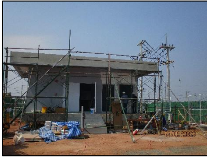
(1) การก่อสร้างอาคารสถานีควบคุมและปรับลดความดันก๊าซธรรมชาติ (Gate Station)
