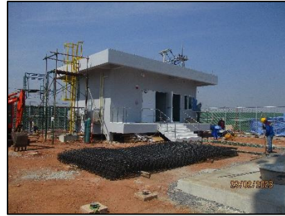
(1) การก่อสร้างอาคารสถานีควบคุมและปรับลดความดันก๊าซธรรมชาติ (Gate Station)
